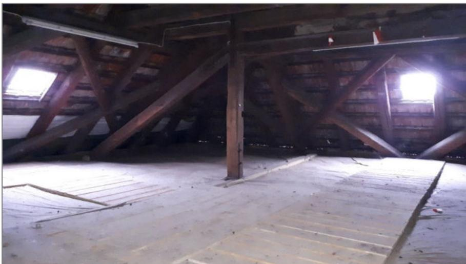
Die oberste Geschossdecke ist zwischen den Deckenbalken mit ca. 16 cm Mineralwolle gedämmt. Lediglich der Eingangsbereich zum Dachboden ist wegen der nach innen aufschlagenden Zugangstüre ungedämmt.
