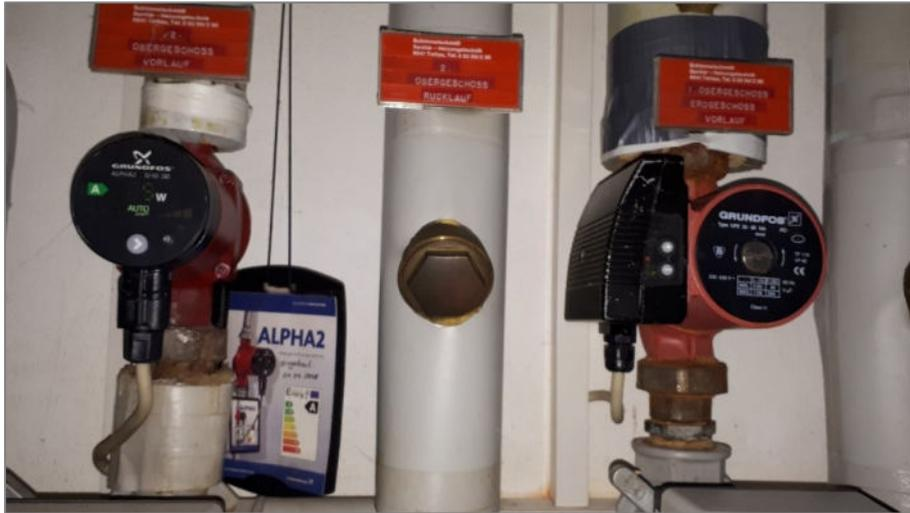
Die Heizungspumpe (links) für den Heizkreis 2. OG ist bereits eine leistungsgeregelte Hocheffizienzpumpe.
