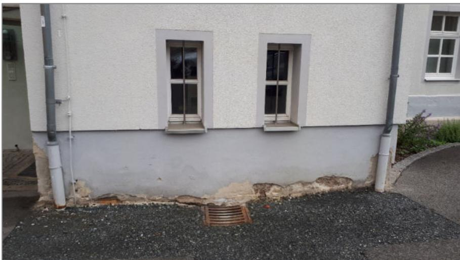
Teilweise sind die Erdgeschosswände sowohl im Außen als auch im Innbereich durch aufsteigende Feuchtigkeit beeinträchtigt.
