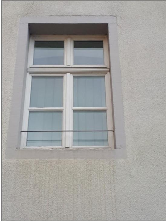
Ein Großteil der Fenster hat außenseitig kein Fensterblech. Dies führt zu Vermosung der Fenstersteine und Tropfstreifen unter den Fenstern an den Außenwänden. Bei Austausch der Fenster sollten dringen Fensterbleche mit ausreichend Überstand eingebaut werden.
