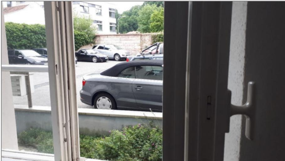
*Insgesamt sind alle Fenster in keinem guten Zustand und sollten erneuert werden. Die Rahmen, insbesondere die Wetterschenkel, sind durch die Witterung deutlich angegriffen.*
