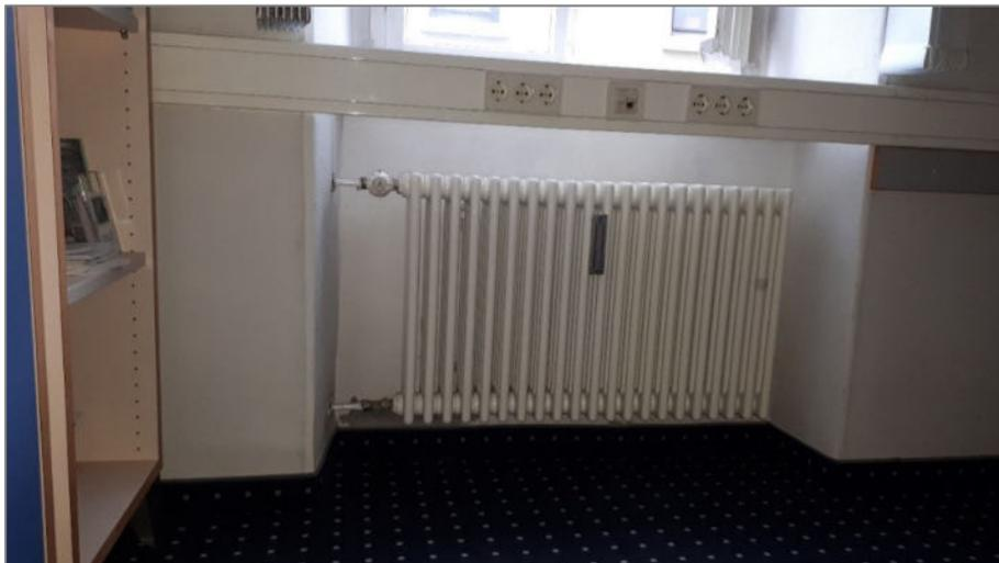
Die Wärmeabgabe erfolgt durch Gliederheizkörper, die in Heizkörpernischen installiert sind. Durch die Nischen reduziert sich die Außenwanddicke um ca. 30 cm, was in diesem Bereich zu erhöhten Wärmeverlusten führt.
