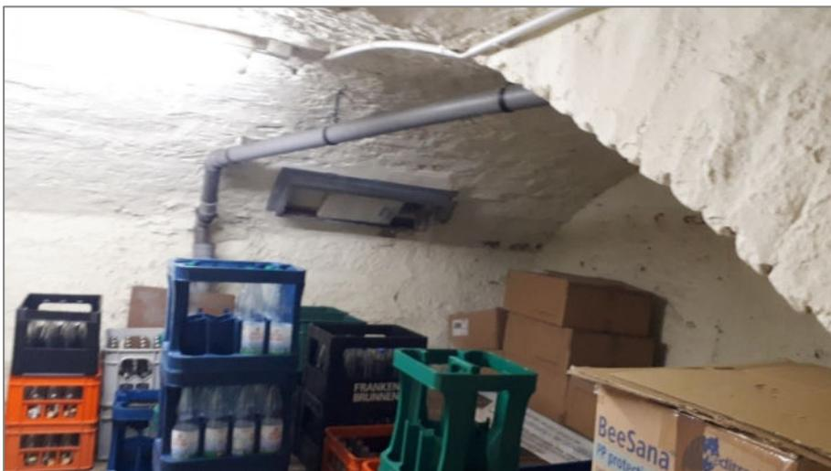
Das Gebäude ist nur teilweise unterkellert. Der Gewölbekeller hat nur eine lichte Raumhöhe von ca. 1,6 m. Hier im Bild eine Lüftungsklappe, die für geringen Luftwechsel sorgt.
