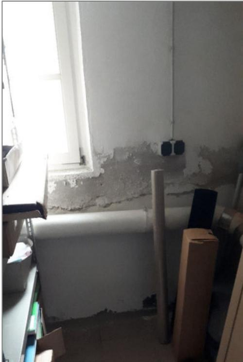
Grundsätzlich sollen vor den Außenwänden ungedämmter Gebäude keine Möbel platziert sein, um ein Ablüften der Wände zu gewährleisten. Um längerfristige Bauschäden zu vermeiden, müssen an den betroffenen Stellen geeignete Sanierungsmaßnahmen erfolgen.
